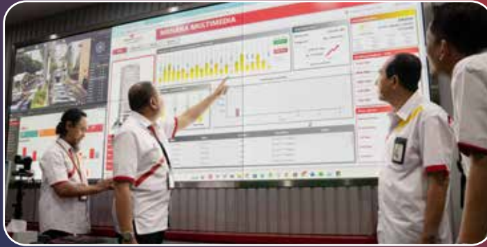
Gambar 32. Pemantauan Energi Gedung melalui dashboard IBMS
